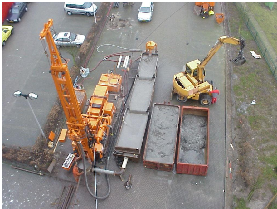
Figuur II-1: Boorstelling zuigboren
